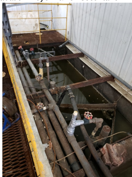
Figure 2 – Réparation de tuyauterie
